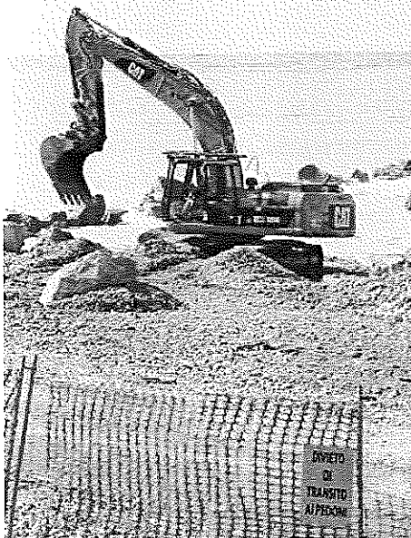
Un intervento di ripascimento sulle spiagge di Bordighera
